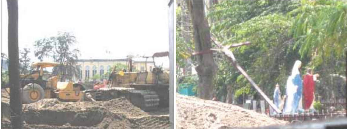
Beginn der Bauarbeiten auf dem Grundstück am 25.09.2008
