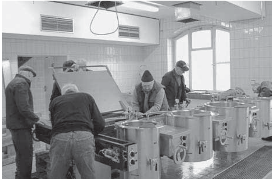
Ehrenamtliche der IGFM bauen die Edelstahlgroßküche des ehemaligen Internats des Peter-Wust-Gymnasiums in rund zehn Stunden ab.
